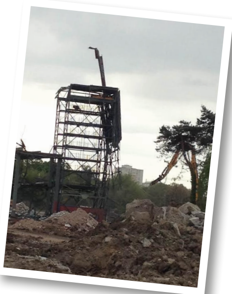
Démolition en cours
